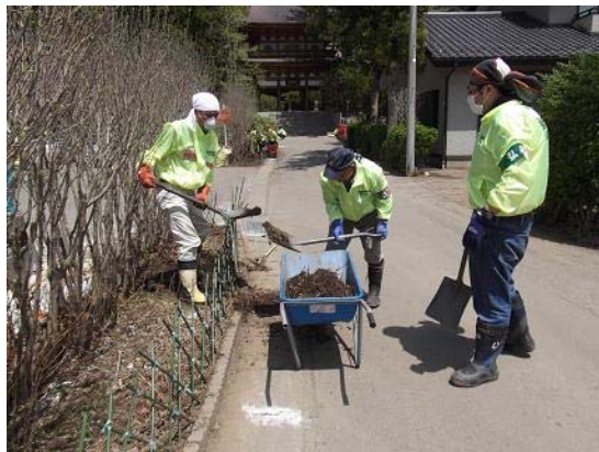
海蔵院周辺の瓦礫撤去
