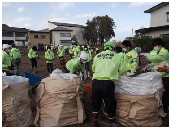
撤去した瓦礫の土嚢への詰め込み
