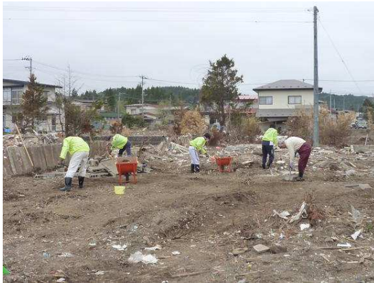
被災者と一緒に瓦礫撤去
