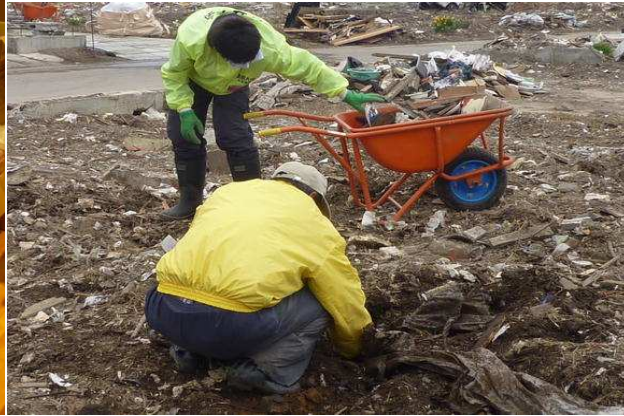
被災者宅の瓦礫撤去の様子
