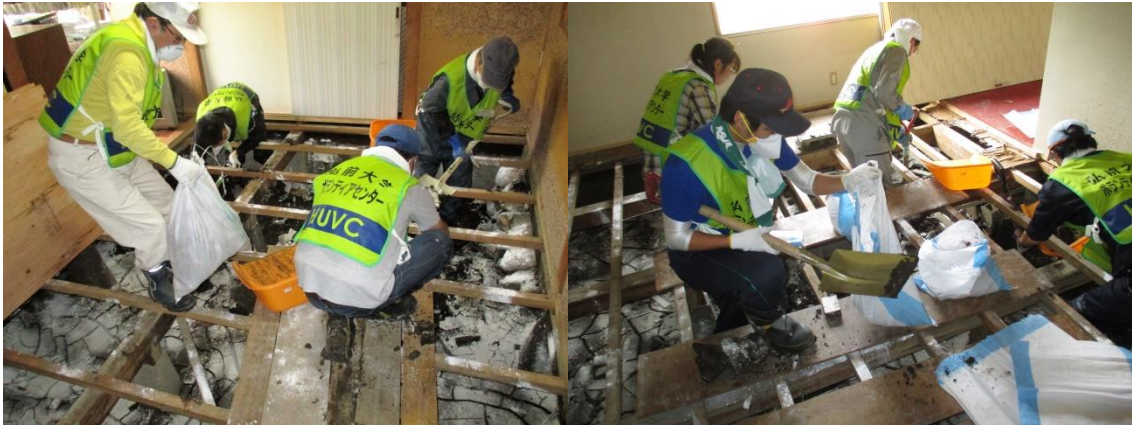
泥上げ作業の様子
