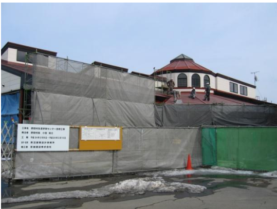
生涯学習センターも、改修工事に入っていました。
