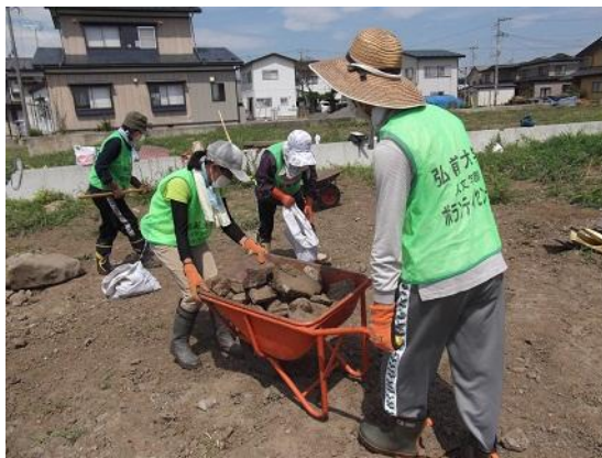
津波で流入した石の拾い出し
