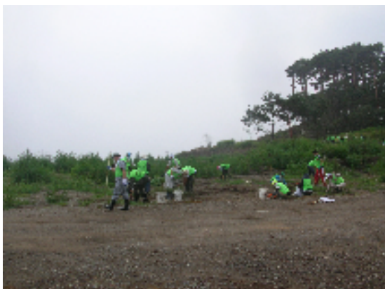
作業開始直後、雑草が生い茂っている状態
