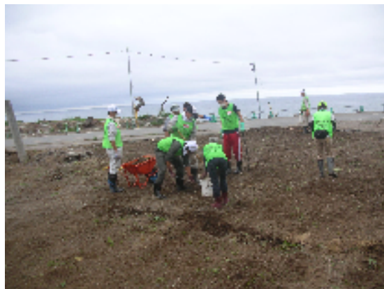
作業風景② 瓦礫を撤去している様子
