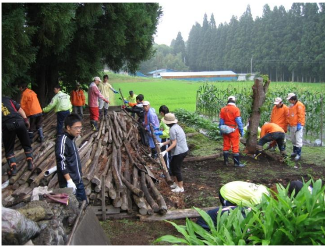
宿泊施設建設のため、木を退かしたり、切ったり。
