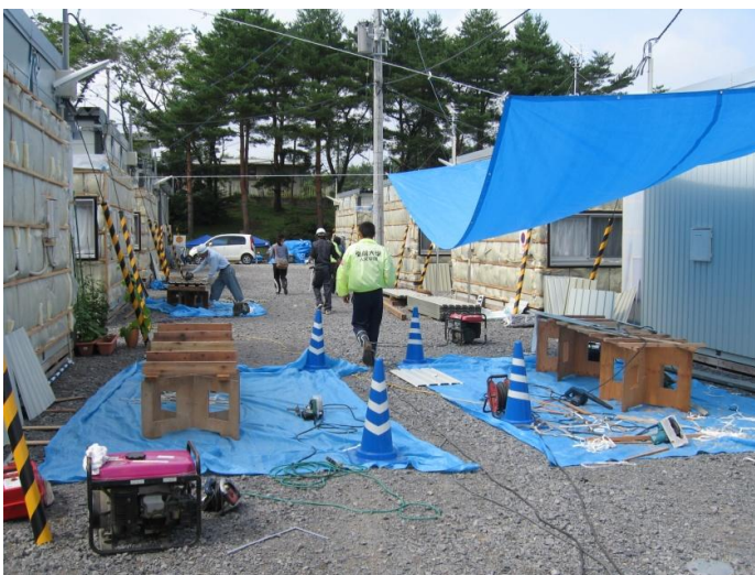
野田中学校の仮設住宅は、今日は断熱材の工事中。
