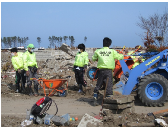
写真2 側溝の泥上げの様子。スコップなどで泥をあげる人と運ぶ人に分担しつつ、どんどん片付ける
