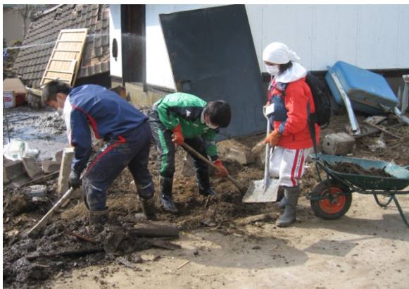
側溝の泥上げ。瓦やコンクリート片等が行く手を阻む。
