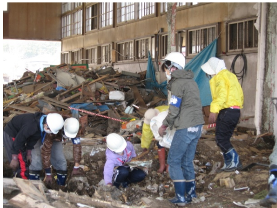
倉庫の中で瓦礫撤去、泥出しを行う。
