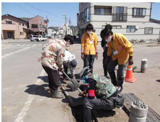
役場そばの公道の側溝清掃作業の様子
