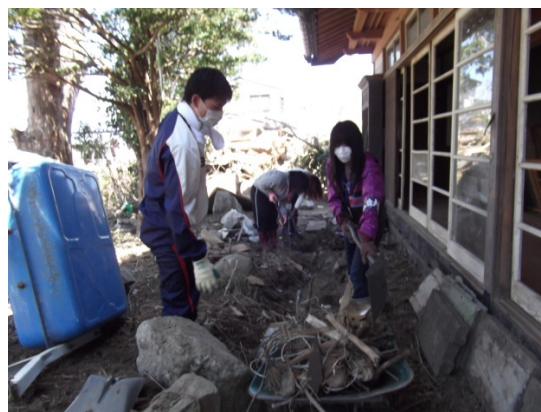
被災者宅の瓦礫撤去の様子
