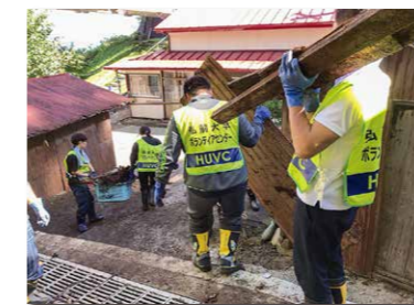
がれきの撤出もすべてマンパワーで
