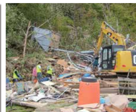
倒壊した家屋と災害ゴミ分別の様子
