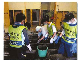
床板を剥がしての泥出し作業
