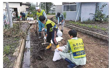
滞積した泥を土のう袋に詰めました
