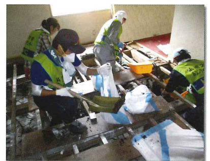
泥上げ作業の様子
