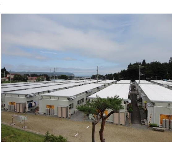
野田中学校グラウンドに立ち並ぶ仮設住宅
