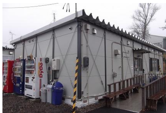
野田中学校仮設住宅集会所
