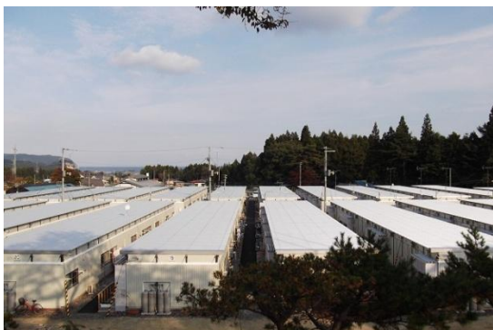
野田中学校仮設住宅
