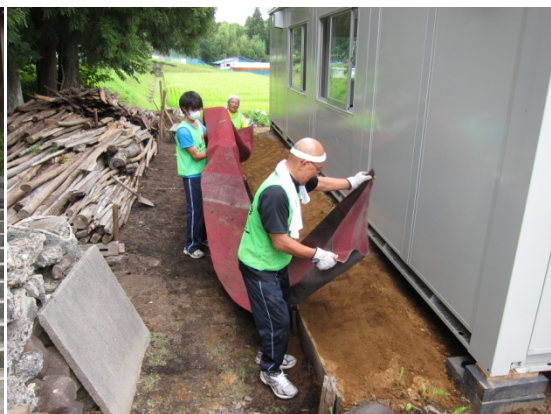
チーム北リアスの現地事務所の整備作業
