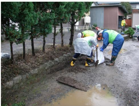
図 1 細い側溝の泥あげ
