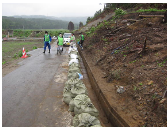
作業終了時の側溝の様子
