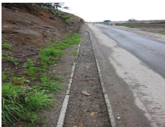
作業開始前の側溝の様子
